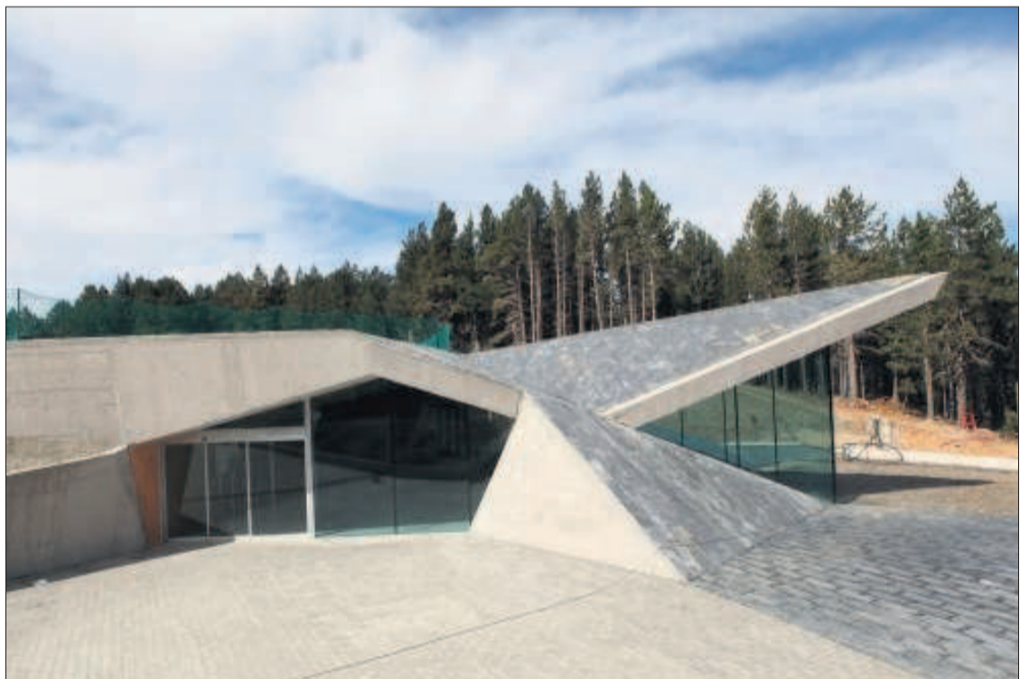
Obres de construcció de les noves instal·lacions de Naturlàndia.
